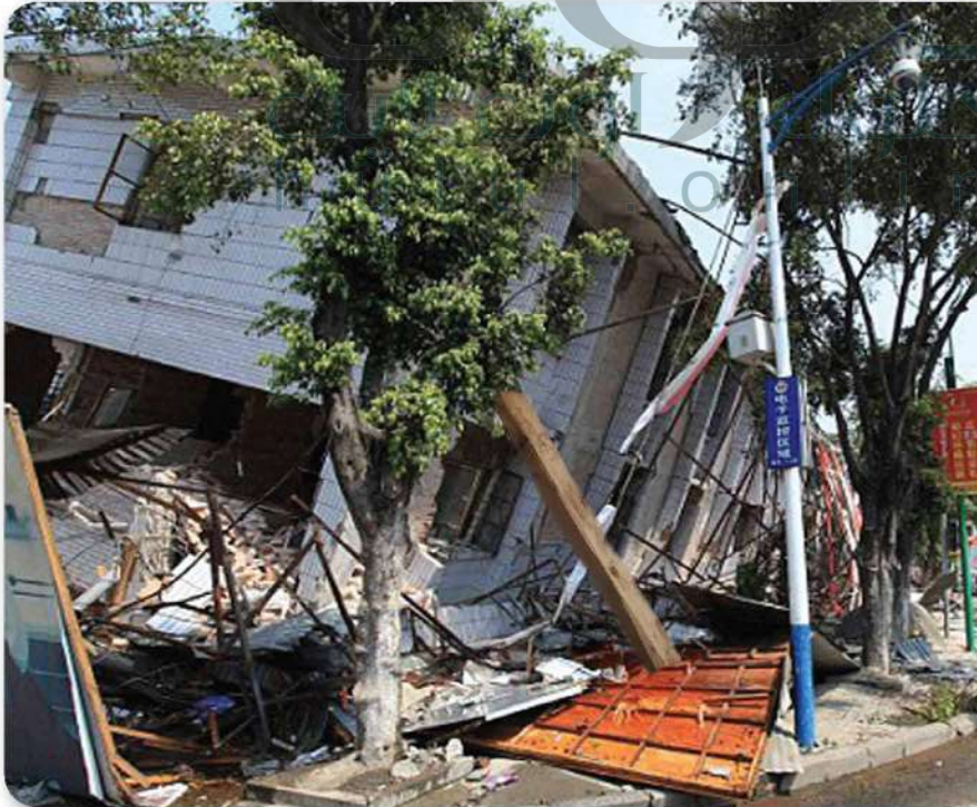
الشكل 16-7 المباني الخرسانية (الأسمتية) هشة غالباً، ويمكن أن تتلف بسهولة إذا وقع زلزال؛ فالمبنى الظاهر في الصورة أزيح من فوق أساسه عندما حدث الزلزال، وتم إسناده بعمود من الخشب.
