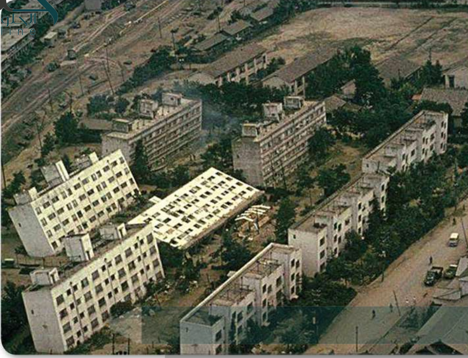
الشكل 19-7 يحدث تسيل في التربة الضعيفة التماسك عندما تنتشر اهتزازات زلزالية فيها، فتسلك سلوك الرمال المتحركة.
